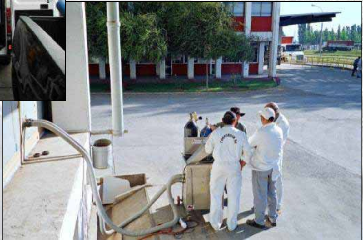
Fumigación de molino de harina de 16000 m 3 con el HDS. San Bernardo, Chile.
