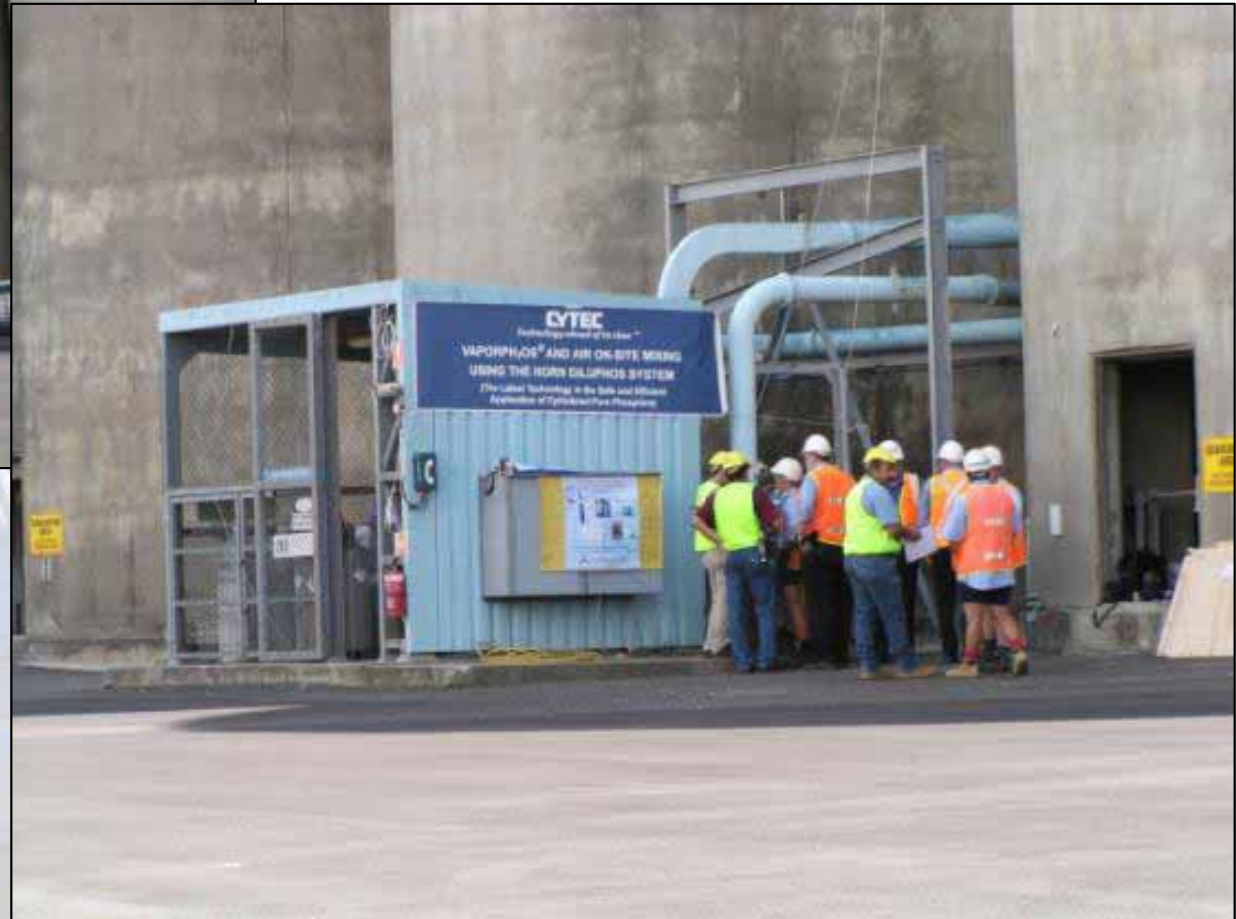
Silos de 4000 toneladas. Brisbane, Australia, año 2003
