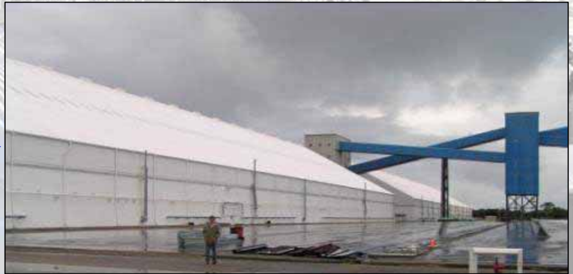
Bodega de Trigo de 600.000 m 3 (Aprox. 300.000 toneladas de trigo)
